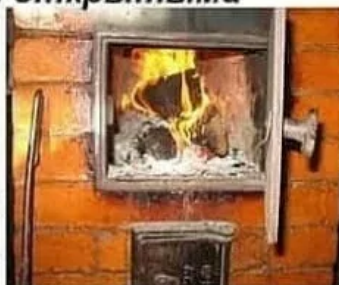
Размер дров должен соответствовать размерам топливника
