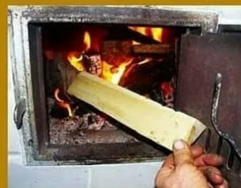
Размер дров должен соответствовать размерам топливника
